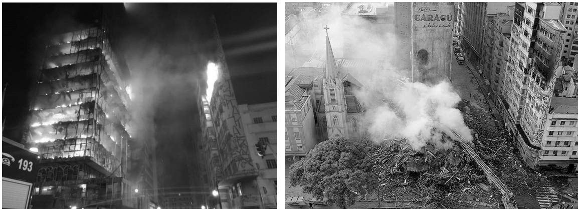
Рис.2. Прогресуюче руйнування багатоповерхової будівлі внаслідок пожежі у Сан-Паулу
