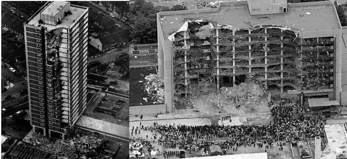
Рис.1. Прогресуюче руйнування: а) будинку «Ronan Point» в Лондоні (вибух газу); б) «Alfred P. Murrah Federal Building» в м.Оклахома (теракт)
