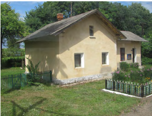
Рис.13. Будинок вокзалу Коропуж. Фото Ю. Рочняк. 2013 р.
