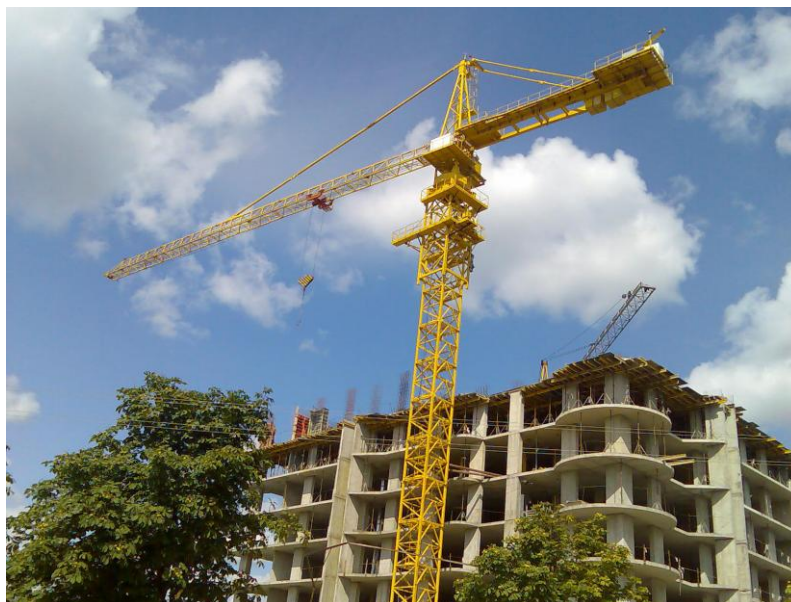
Рис. 1 - Первый отечественный башенный кран нового поколения КБ-471
