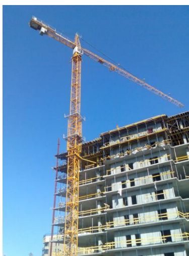
Рис. 3 - Приставной наращиваемый башенный кран фирмы Liebherr
