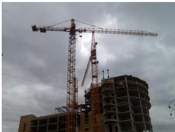
Рис. 6 - Установка двух башенных кранов на одном объекте
