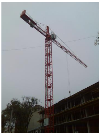
Рис. 2 - Свободностоящий башенный кран WK 5520 SL-6 (с неповоротной башней и балочной стрелой)
