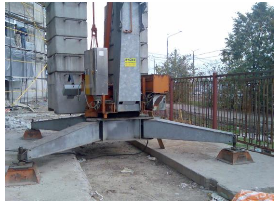
Рис. 3 - Установка быстромонтируемых кранов (IGO 36 и EUROGRU 185.8) на бетонные плиты
