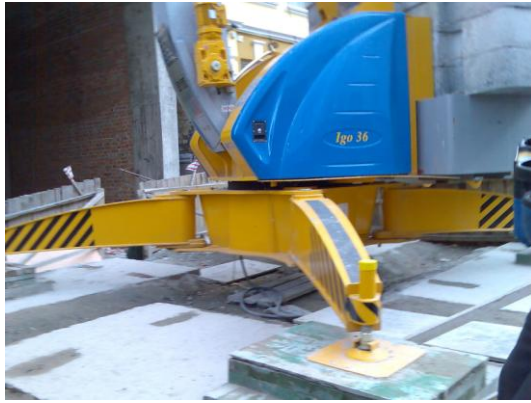
Рис. 3 - Установка быстромонтируемых кранов (IGO 36 и EUROGRU 185.8) на бетонные плиты
