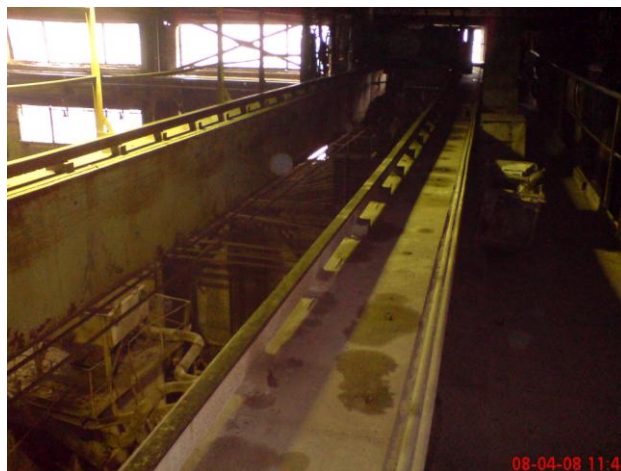
Рис. 4 – Выставка подтележечного рельса на опорные детали
