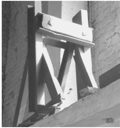
Рис. 4 – Кінцевий упор мостового крана 5т40
