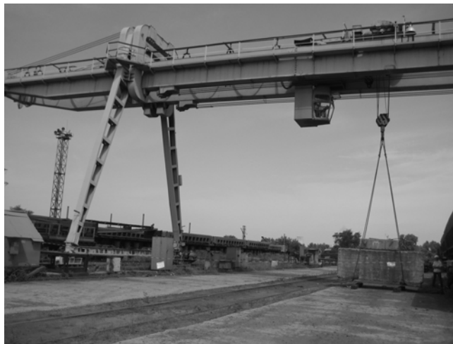
Рис. 2 – Канатные затяжки при усилении металлоконструкции козлового крана грузоподъёмностью 20/5 т, пролётом 32 м
