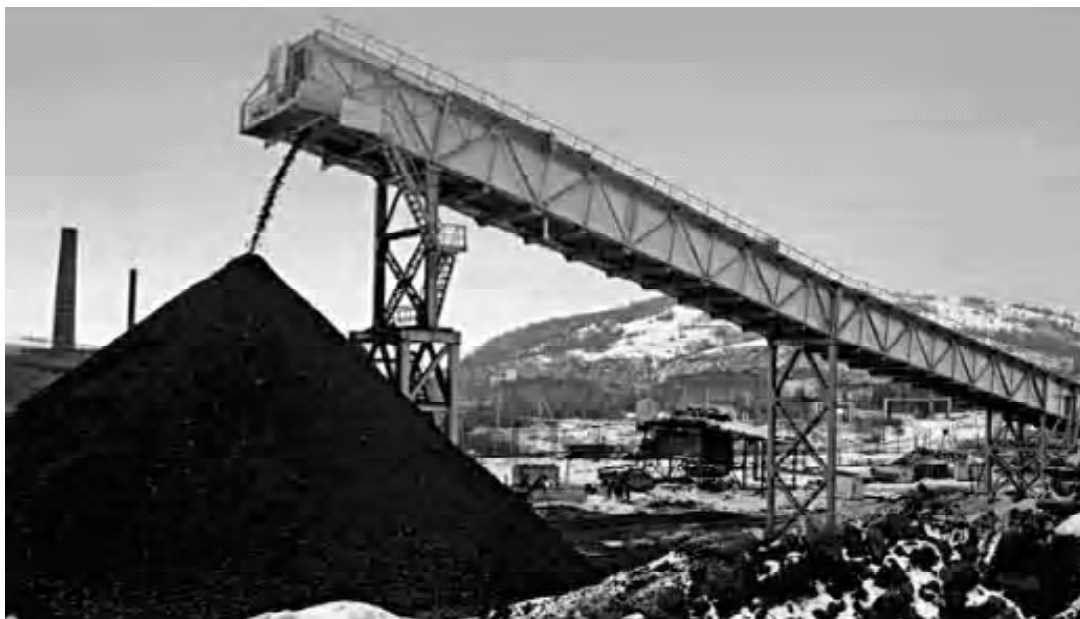
Рисунок 1. Общий вид конструкции решётчатой конвейерной галереи.
