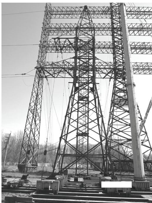
Рисунок 1. Общий вид опоры У110-1.
