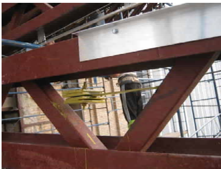
Рисунок 5. Схема пластинчатого гасителя колебаний: а) расчетная схема (1 – ферменная конструкция, 2 – гаситель колебаний); б) установленный гаситель на конструкции фермы.
