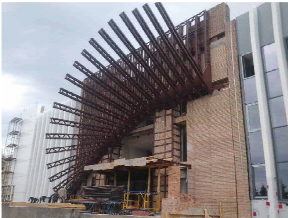
Рисунок 1. Общий вид ферменных конструкций без обшивки.
