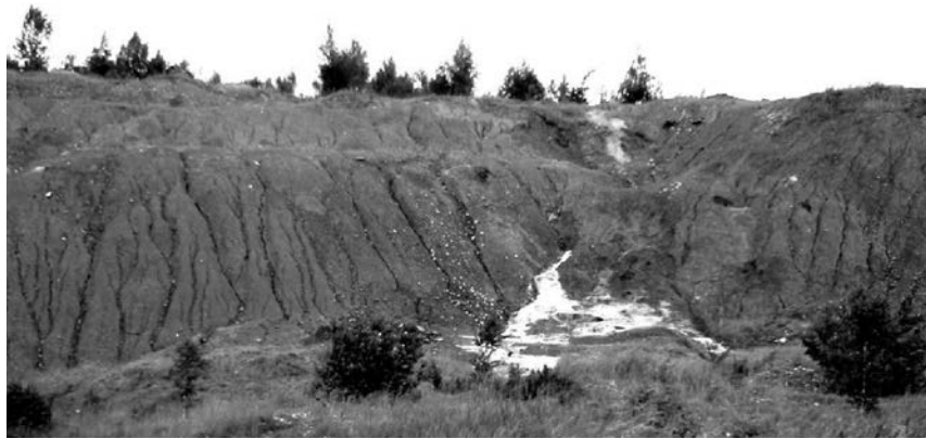
Рис. 15. Заростання збезсолених відкладів, промитих атмосферними опадами, трав'яною, чагарниковою і деревною рослинністю на вирівняних ділянках зі схиловою ерозією бортів, відвал № 1 (м. Калуш).
