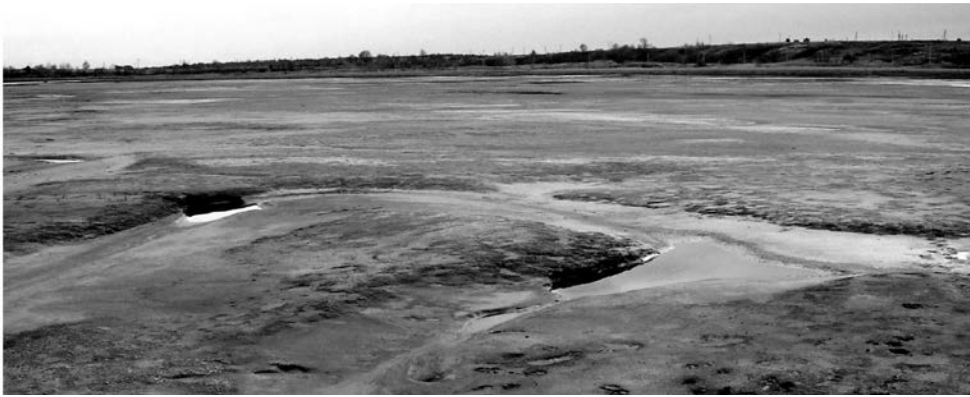
Рис. 11. Закарстованість приповерхневого шару секції № 1 Стебницького хвостосховища.
