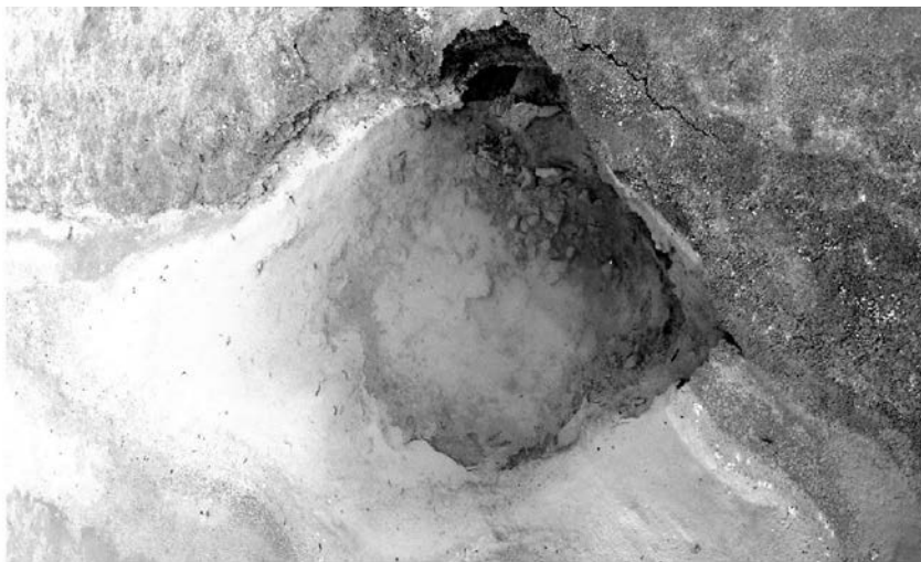
Рис. 12. Тампонування ділянок вилугування й армування уламками соляно-глинистих відвалів гідроізоляційного шару.
