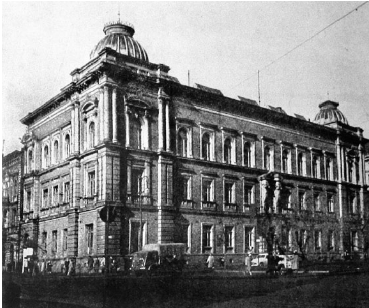
Будівля Академії мистецтв у Кракові. Світлина Т. Кнауса. 1876 р. З видання: Materialy do dziejów Akademii Sztuk Pięknych d Krakowie. 1816–1895. Wroclaw, 1959. S. 3.
