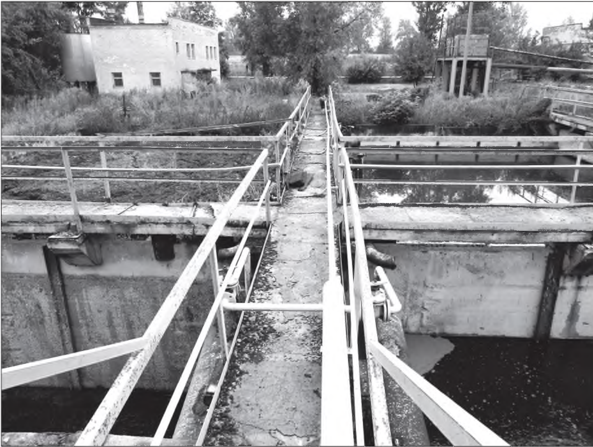
Рис. 2. Очисні споруди біологічного очищення КП «Боярка-водоканал», аеротенки
