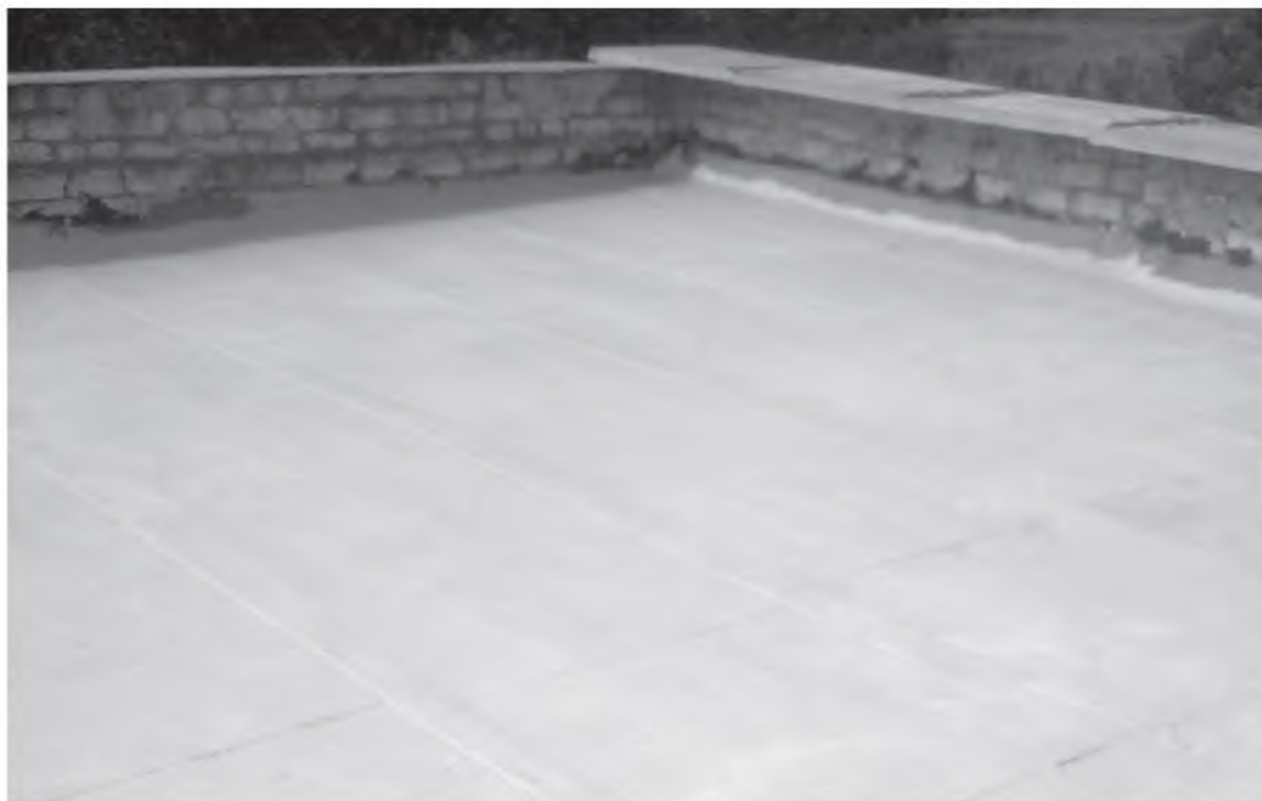
Рис. 3. Технічний стан покрівлі після ремонту
