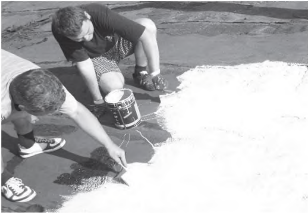
Рис. 2. Проведення ремонтно-відновлювальних робіт на покрівлях ГТС
