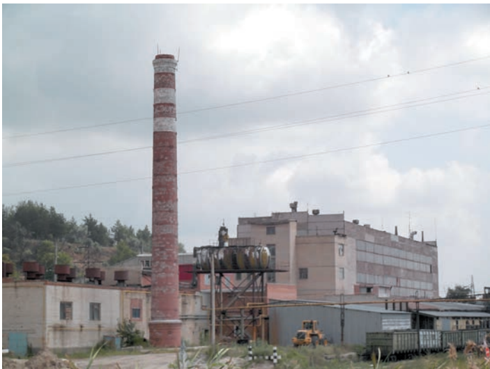
Фото 5. Обогащительная фабрика Новосёловского горно-обогатительного комбината
