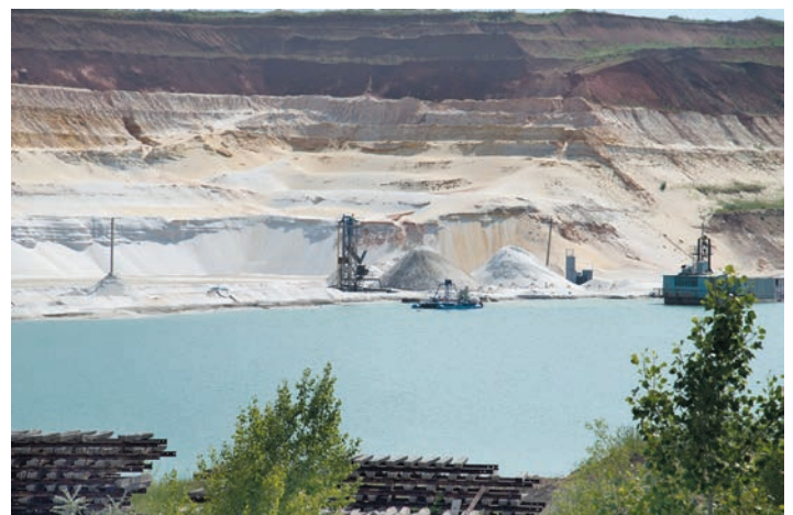
Фото 6. Полный разрез, вскрытый южной стенкой Южного карьера. Кровля пласта кондиционных кварцевых песков находится на уровне верхушек электрических опор
