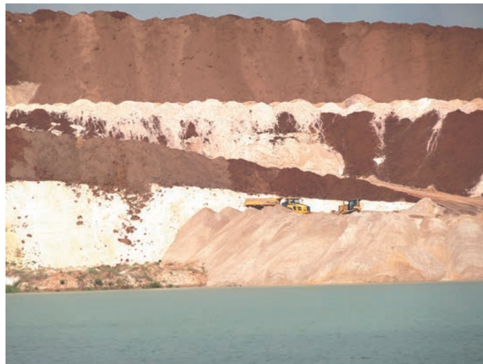
Фото 7. Засыпка отработанной части Южного карьера вскрышными породами
