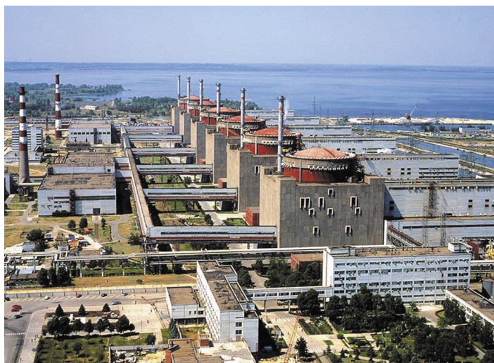
Фото 1. Запорізька атомна електростанція – найпотужніша в Європі
