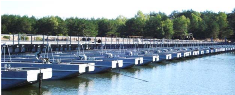
Рис. 7. Загальний вигляд руслової частини наплавного мосту
