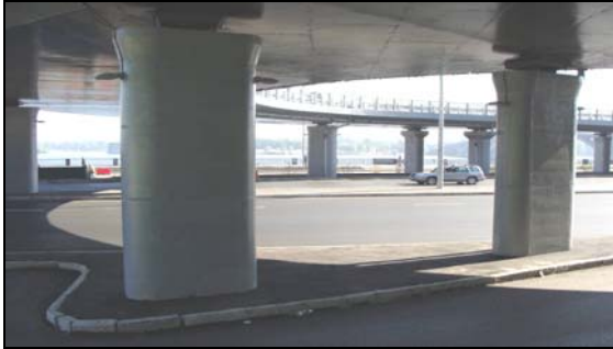
Рис. 3. Загальний вигляд споруди на кривій з каркасним армування прогонової будови
