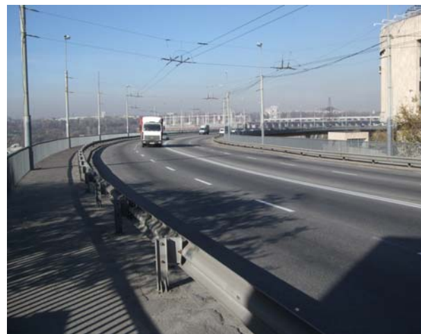
Рис. 1. Общий вид проезжей части эстакады
