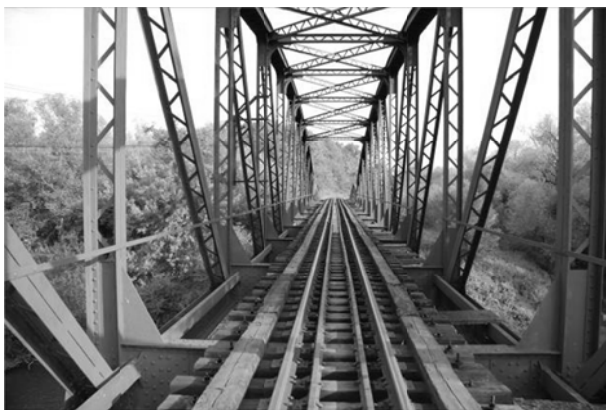
Рис. 3. Мостове полотно мосту на ПК 191+1,4
