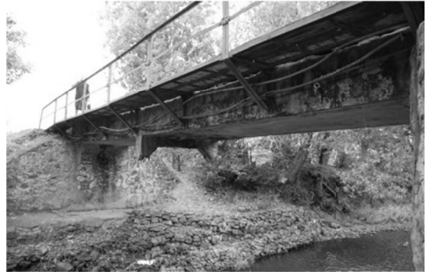
Рис. 4. Загальний вигляд мосту на ПК 429+04,9
