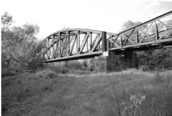
Рис. 2. Загальний вигляд мосту на ПК 191+1,4
