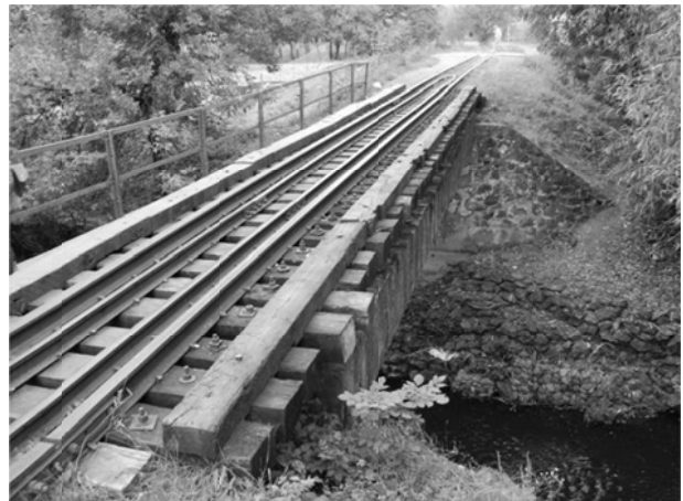
Рис. 5. Загальний вигляд мостового полотна
