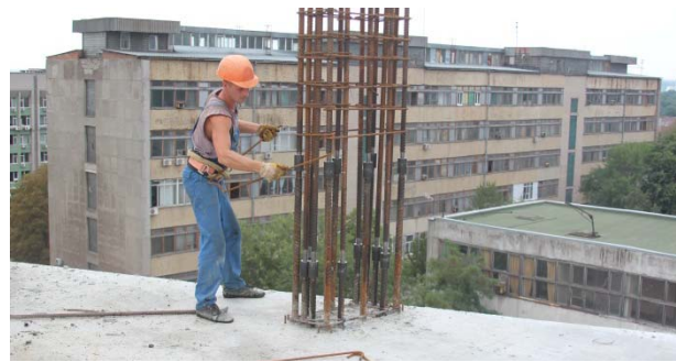
Рис. 5. Соединение арматуры каркасов колонн резьбовыми муфтами
