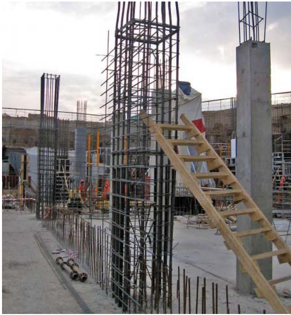
Рис. 3. Соединение арматуры каркасов колонн внахлестку
