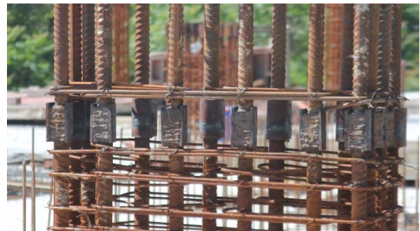
Рис. 2. Соединение арматурных стержней на стальной скобе-накладке. Визуальный контроль
