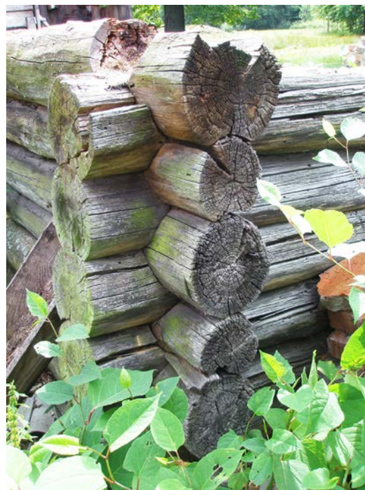
Зруб з колод з верхньою односторонньою овальною чашкою. с. Лобна Любешівського р-ну Волинської обл.
