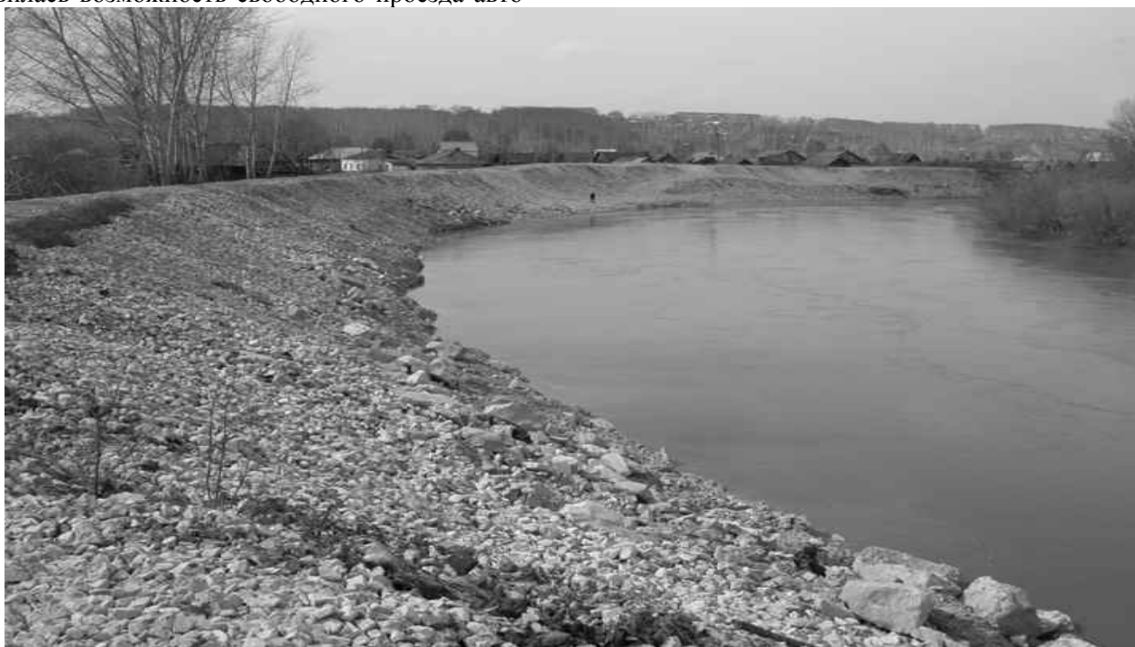
Рис. 2. Каменная наброска. Защитная дамба на р. Ирень, г. Кунгур Пермского края
