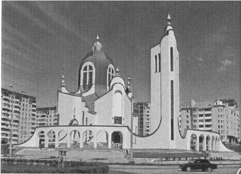
Рис. 4. Собор духовного центру Зарваницької Матері Божої в с. Зарваниця Тернопільської області. Архітект. М.Нетриб'як
