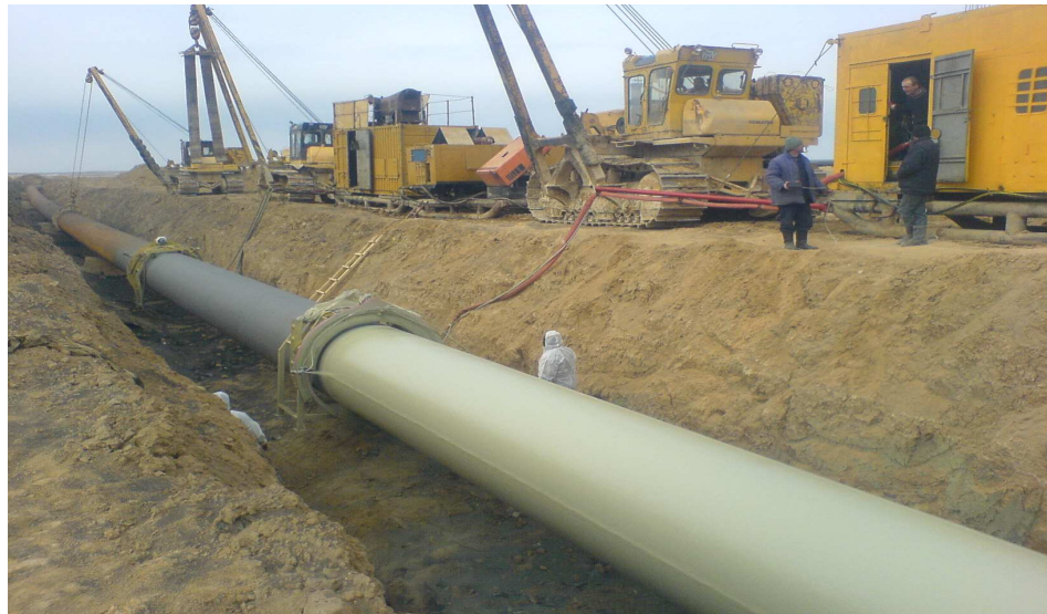
Рисунок 3 – Комплекс для капітального ремонту трубопроводів КРТ
