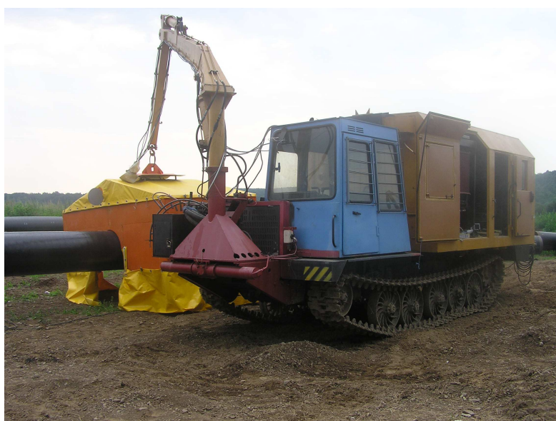
Рисунок 6 – Зварювання стиків. Комплекс для автоматичного зварювання порошковим дротом з примусовим формуванням шва КПАЗ
