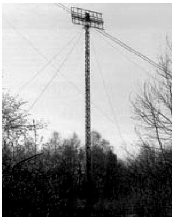
Рис. 3. Вишка (висота 30...50 м) з антеною бістатичної РЛС «Струна» (ОАО НИТЕЛ, РФ)
