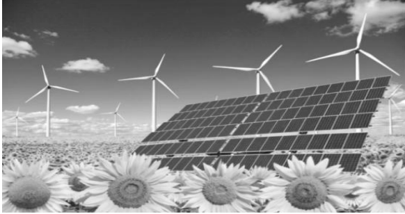
Рис. 4. Сонячна електростанція та вітрогенератори
