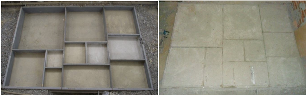
Рис. 2. Опалубка для цементобетонных плит с подготовленными основаниями (слева) и с уложенным бетоном (справа)
