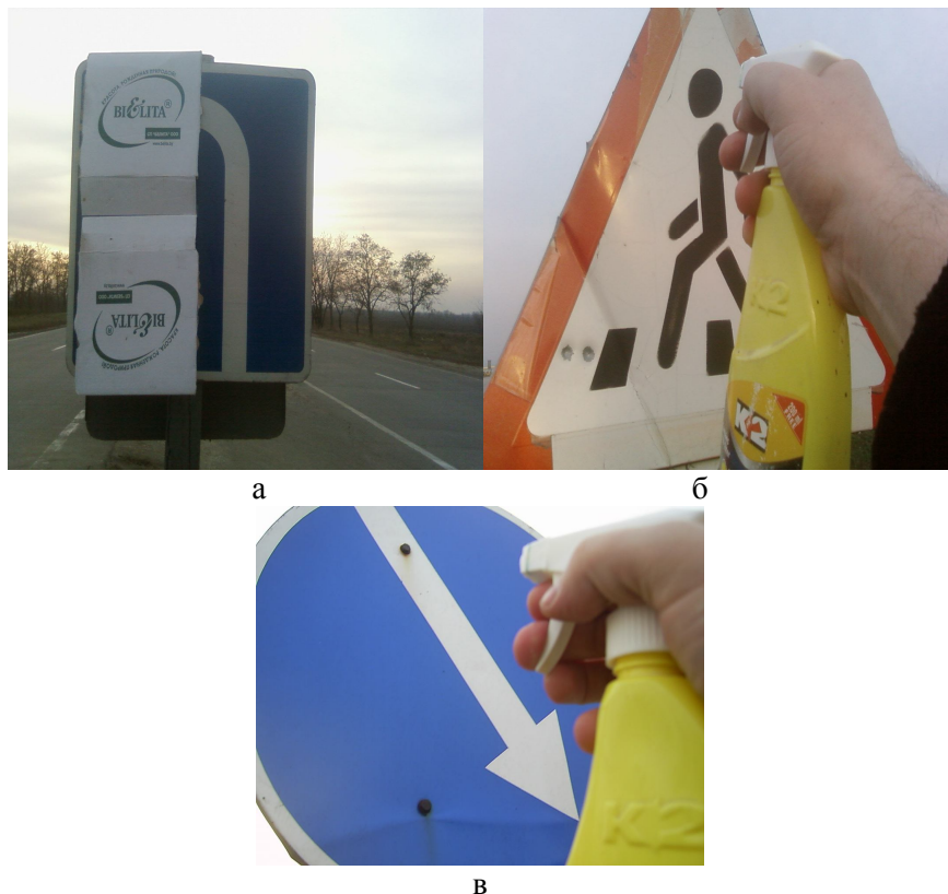
Рис. 2. Нанесення рідкого воску на дорожні знаки
