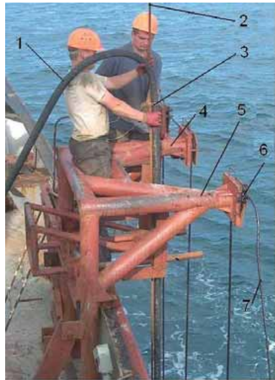
Рис. 6. Процесс бурения скважины
