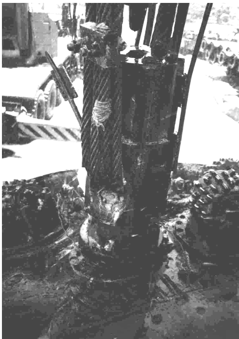
Рис. 2 Клиновая ловушка в колодце Д 1 после извлечения бура Ø3970 мм массой 55 т с глубины 792 м 21 февраля 2000 года
