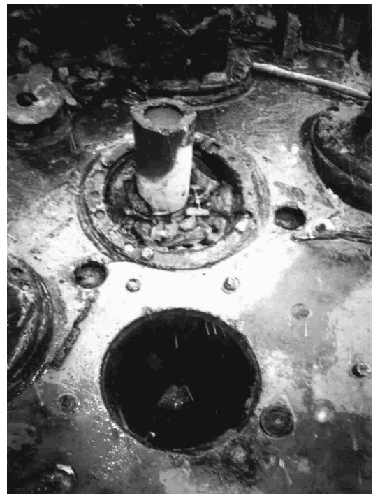
Рис. 3. Обломки клиновых ловушек в колодцах защемленных породой
