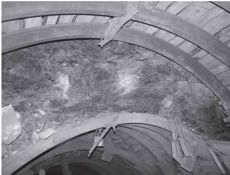
Рис. 6. Общий вид кровли грузового ходка уклона пл. m_4^0 гор. 450 м после демонтажа деформированной рамы крепи на экспериментальном участке
