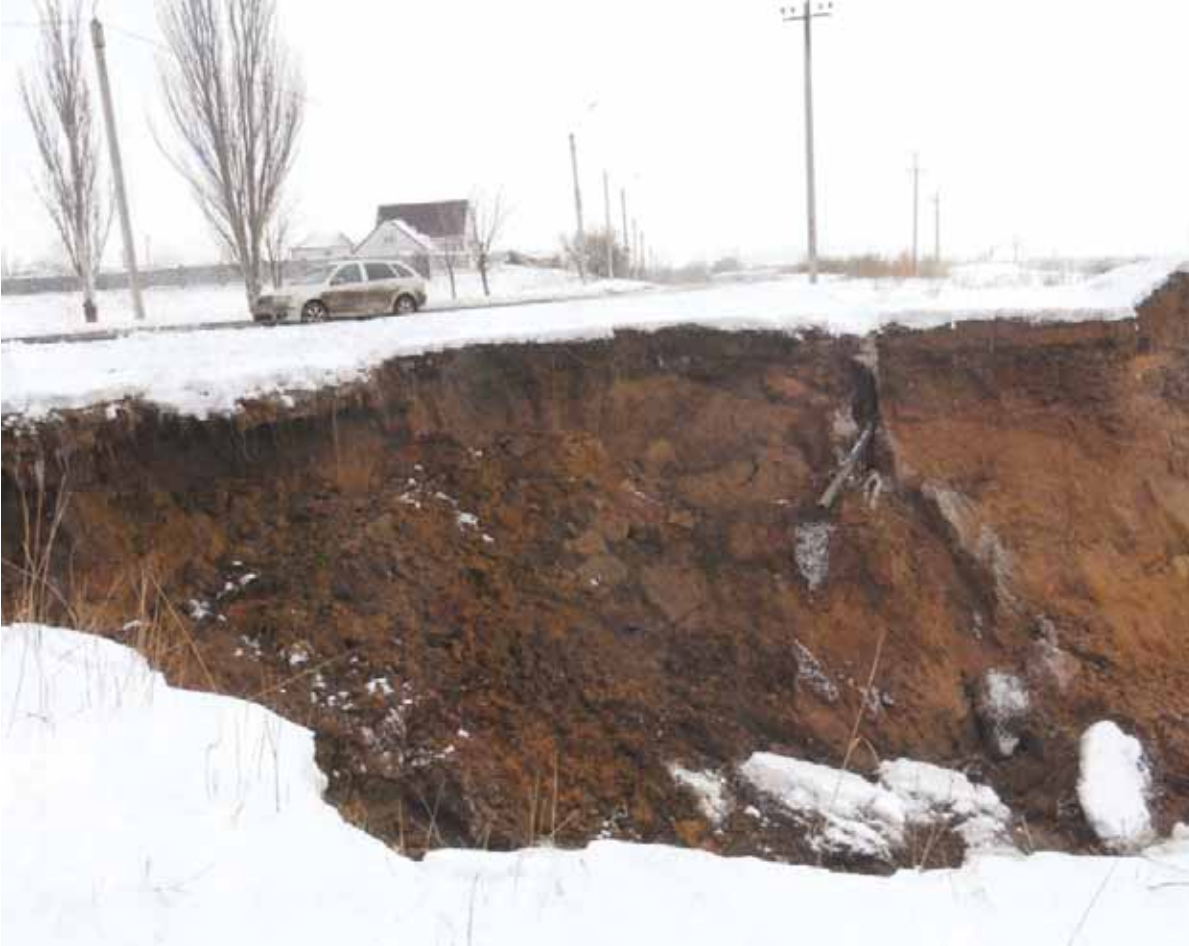
Рис.2. Оползень, который привел к разрыву напорного водовода и трассы канализации
