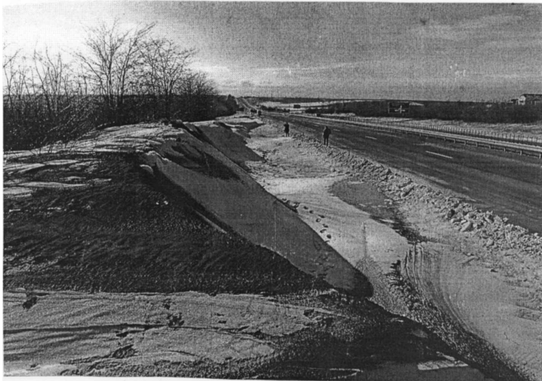
Рис. 1. Общий вид снего-мелкозёмного наноса, образованного продуваемой лесополосой
