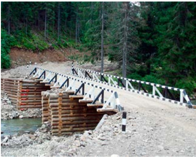
Рис. 2. Двопрогінний комбінований міст на автодорозі Менчільського лісництва
