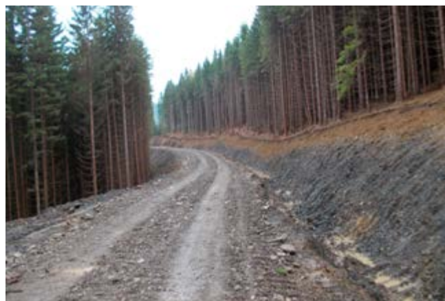
Рис. 1. Лісова автодорога у Піскавському лісництві, прокладена гірським схилом
