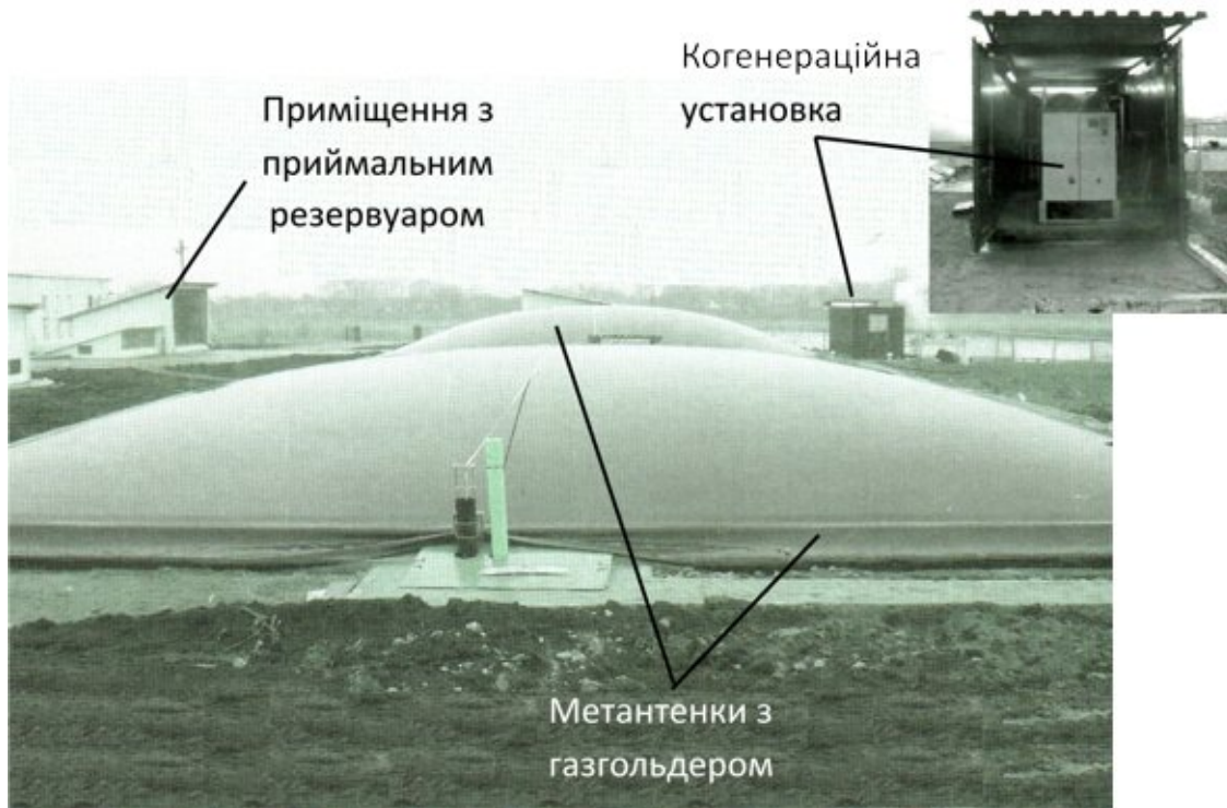
Рис. 1. Біогазова установка на свинофермі компанії “Агро-Овен” у селі Єленівка Магдалинівського району Дніпропетровської області.
