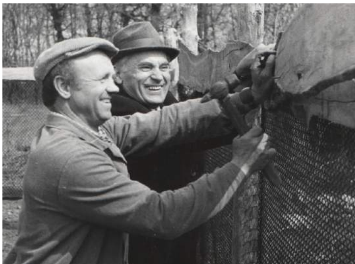
На будівництві стайні, суботник 20 квітня 1985 р.
