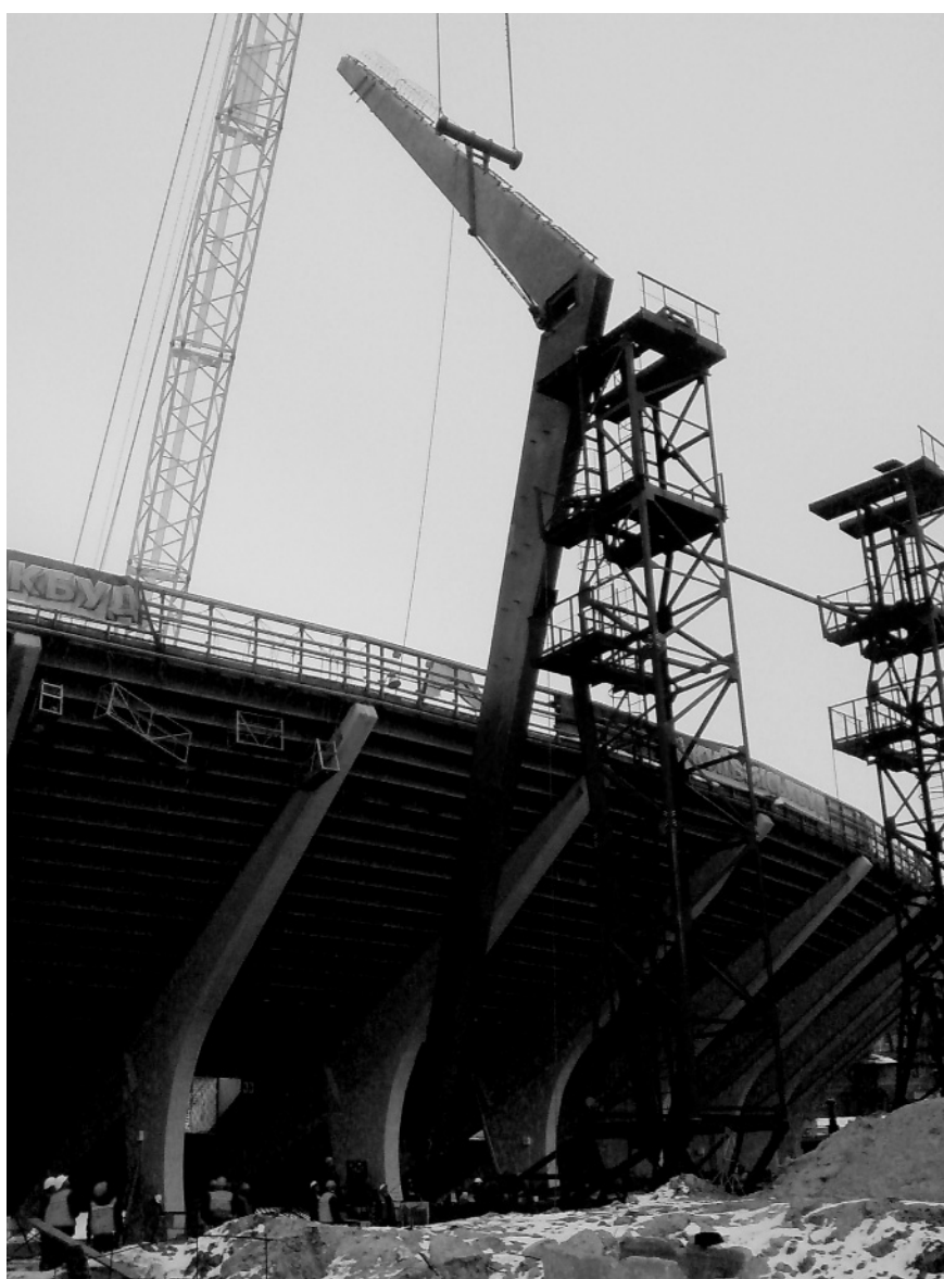
Рис. 2. Загальний вигляд монтажу колони
