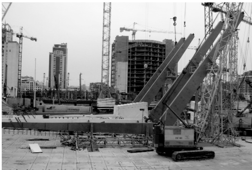
Рис. 1. Загальний вигляд розміщення колон на стенді
