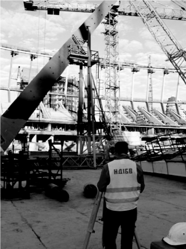
Рис. 4 Проведення геодезичних робіт при складанні колони
