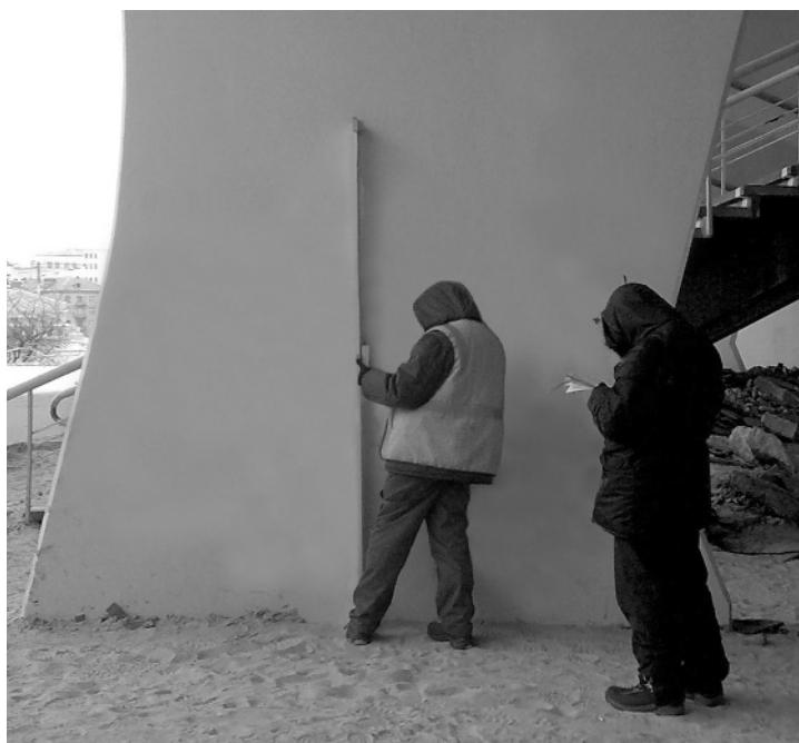
Рис. 8. Моніторинг опор моніторингу опор другого ярусу спортивного комплексу «Олімпійський»
