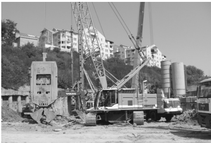
Рис. 3. Устройство комбинированного «бареттно-плитного» фундамента при строительстве высотного комплекса MIRAX PLAZA в Киеве
