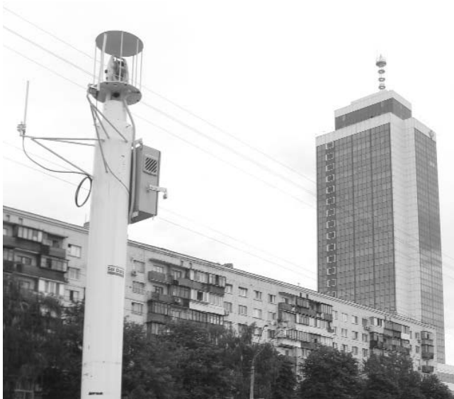
Рис. 6. Установка приборов для наблюдения за деформациями, осадками прилегающего здания
