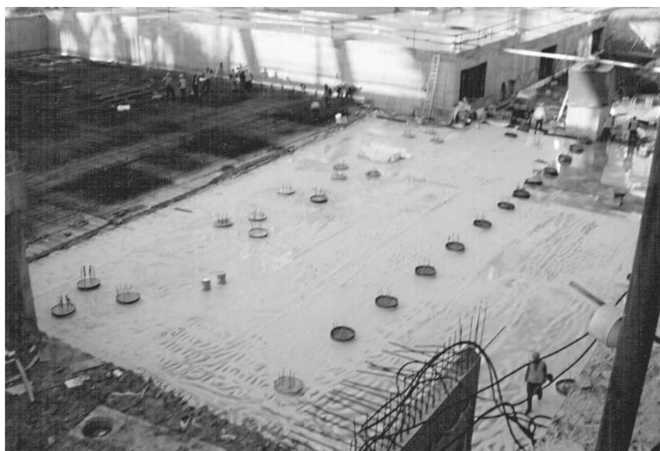
Рис. 1. Внешний вид гидроизоляции днища
