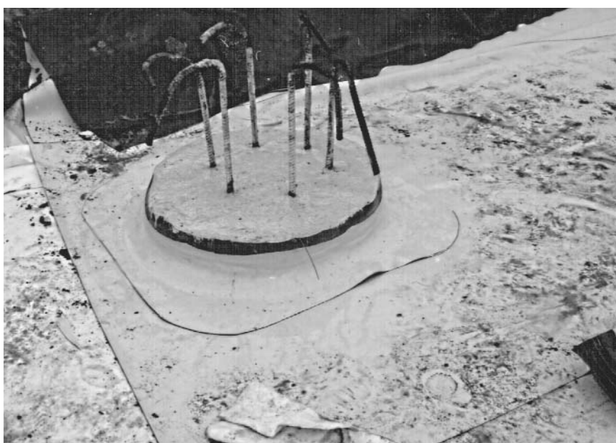
Рис. 3. Усиление гидроизоляции в месте примыкания к бетонной свае
