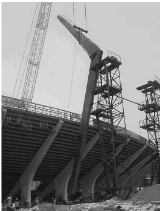
Рисунок 9. Загальний вигляд монтажу колони
