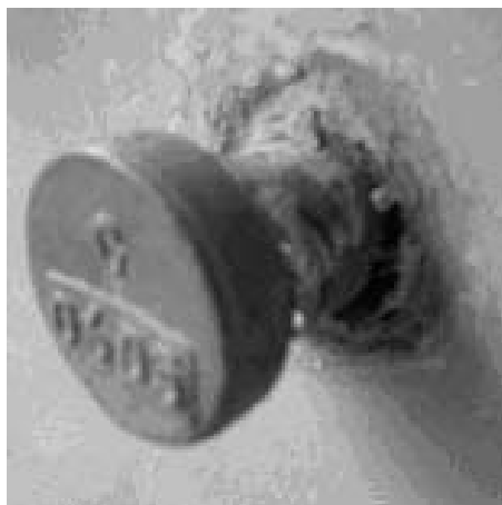
Рисунок 7. Загальний вигляд встановленого репера на опорі по осі 15
