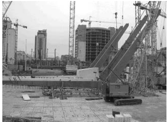
Рисунок 8. Загальний вигляд розміщення колон на стенді
