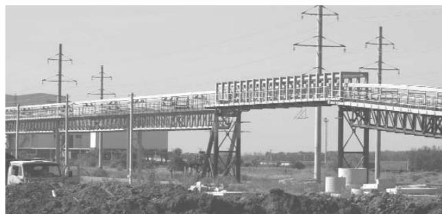
Рисунок 1. Участок КЛК с мостовым переходом
