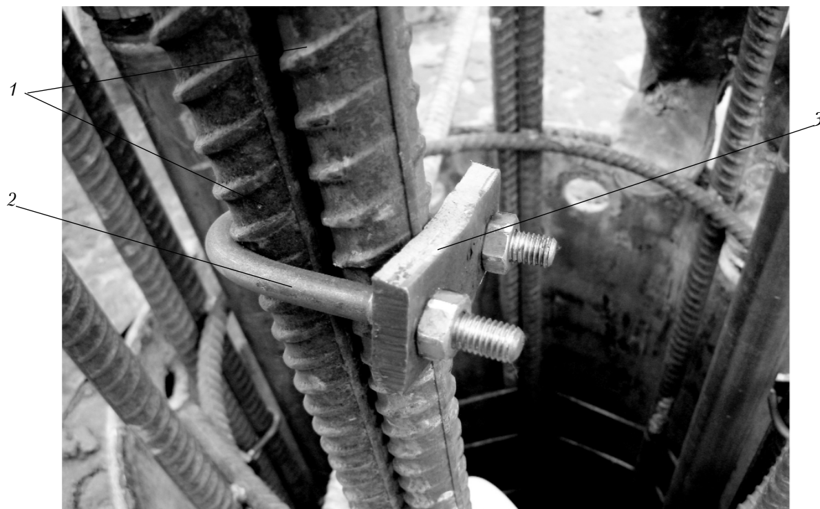
Рис. 7. З'єднуючий арматурні стрижні металевий хомут:
