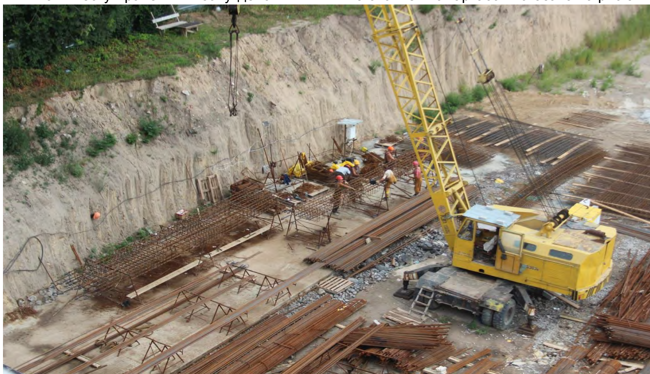
Рис.5. Общий вид арматурной площадки по изготовлению каркасов
