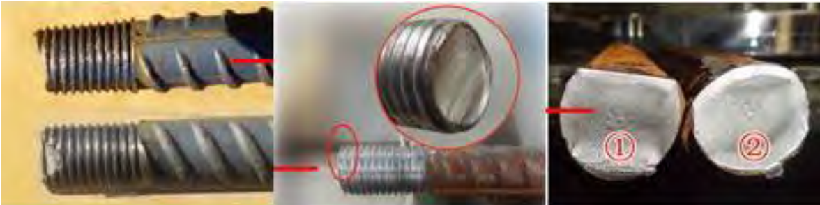
Рис.1. Деформации арматурного стержня при рубке и газопламенной резке
