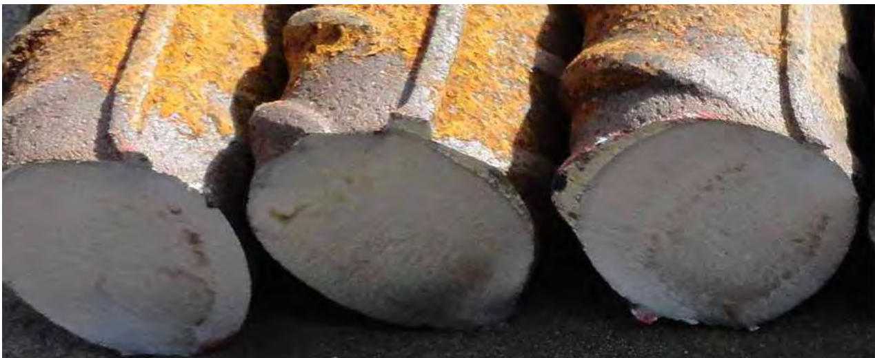
Рис.2. Плоскость арматурного стержня после реза на ленточнопильном станке
