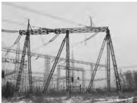
Рис.2. Схема порталной опоры ВЛ
