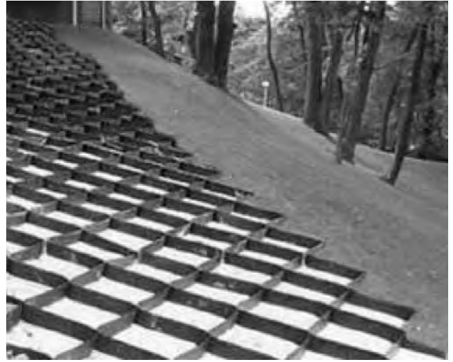
Рис. 4. Приклад встановлення георешітки
