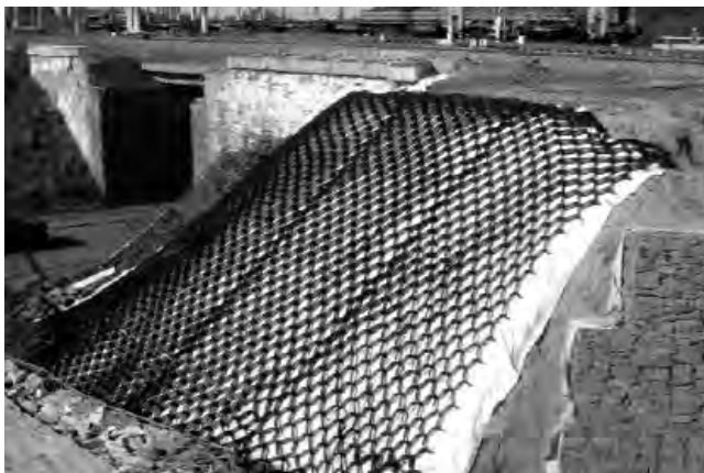
Рис. 1. Приклад влаштування геотекстилю на схилі
