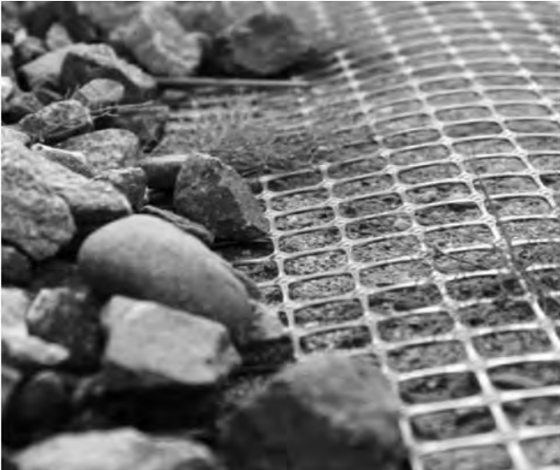
Рис. 3. Приклад встановлення геосітки
