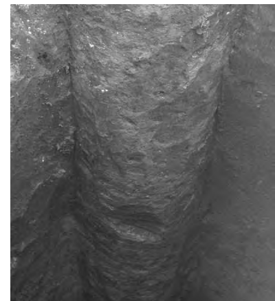
Рис. 2. Готовий ґрунтоцементний елемент в масиві ґрунту, влаштований за бурозмішувальною технологією
