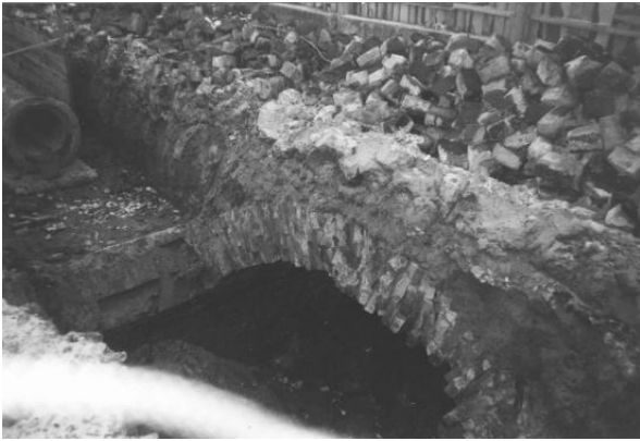
Рис. 5 – Канализационный коллектор, построенный в конце XIX – начале XX столетия в Киеве
